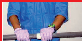
2, dotvarovanie opravenej plochy
