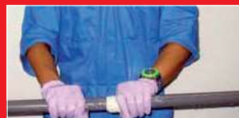
2, dotvarovanie opravenej plochy
