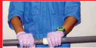
2, dotvarovanie opravenej plochy
